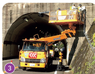
① LED照明取り付け作業状況 ② 柱上訓練の様子 ③ トンネル杭口配管作業に従事 ④ 田辺市武道館の機械設備工事も担当
